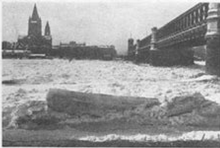
Eisstoß bei der Reichsbrücke in Wien, km 1829.
