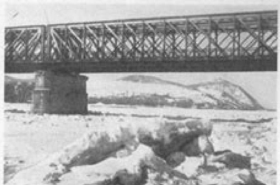
Eisstoß bei der Nordwestbahnbrücke in Wien, km 1931.
